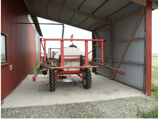
Bild 1. Påfyllningsplatsen på gård 1. Plattan är byggd i anslutning till en byggnad. Tak och vägg på en långsida förhindra nederbörd på plattan. Foto Eskil Nilsson
