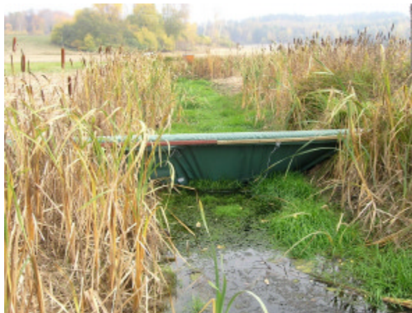
Figur 5. Den flödesavskärande presenningen som monterats i våtmarken i Södra Stene (våtmarken var vid fototillfället avsänkt för skötselåtgärder).
