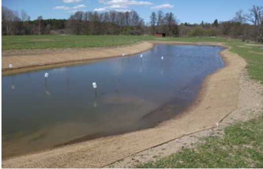
Foto 2. Sedimentationsdelen i Bergaholms våtmark med markerade sedimentfällor.
