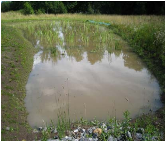
Foto 3. Vegetationen i den nedre delen av det andra vegetationsfiltret (djup 0,3 m) i Bergaholms våtmark den 6 augusti 2010. Vattnet är grumligt efter ett skyfall två dagar innan.
