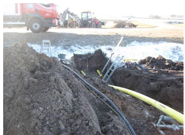
Figur 15. Här syns hur rör för ledningar tryckts genom vägbanken.
