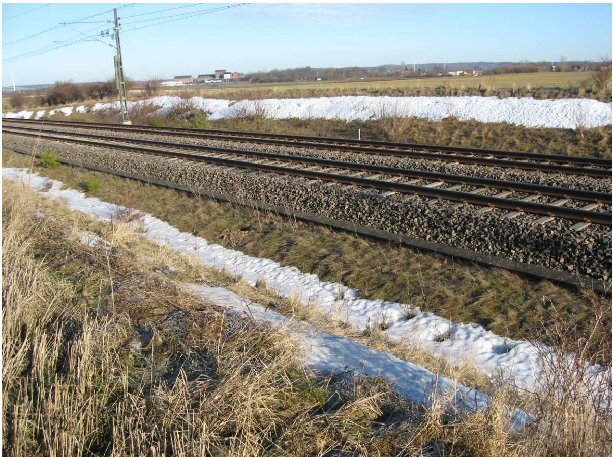
Figur 18. Läget för faunapassage markerat på figur 13 Här är järnvägen under marknivå och avståndet mellan räls och marknivå således mindre än två meter (trafikverkets säkerhetsavstånd) vilket gör att rördragning för faunapassage inte är möjlig utan omfattande schaktarbeten.
