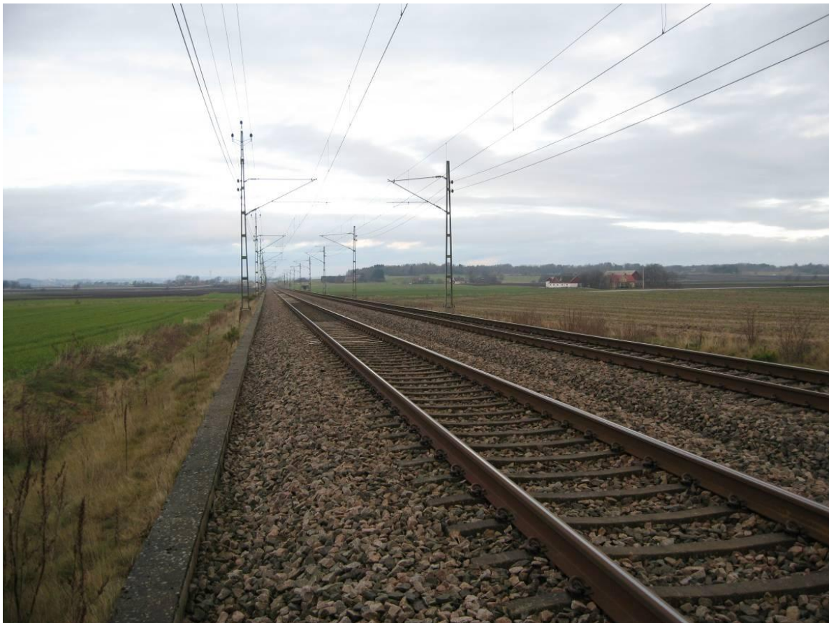
Figur 16. Läget för faunapassage markerat på figur 12. Här är avståndet mellan räls och marknivå över två meter och möjliggör rördragning.
