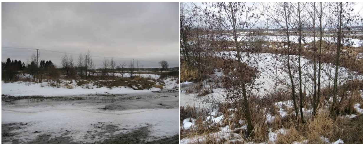
Figur 10. En NYLA-damm anlagd i början på 90-talet. Här har ett hål grävts och massorna lagts i en ring runt dammen som blir närmast kraterformad. Så anläggs inte dammar nuförtiden. NYLA = Nya inslag i Landskapet. På håll ses de upplagda vallarna tydligt i det flacka landskapet och när man tagit sig upp på "kraterkanten" ser man ner längs de branta slänterna mellan de 3-4 m höga alarna som etablerat sig.
