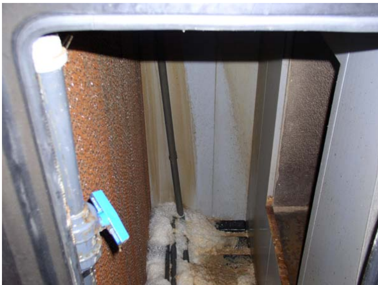
Bild 5: Första filtret som spolas kontinuerligt med vatten.
