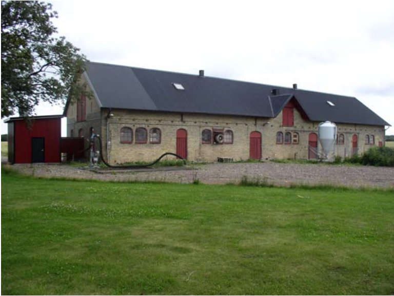
Bild 2: Stallet med det tillbyggda huset för scrubbern.
