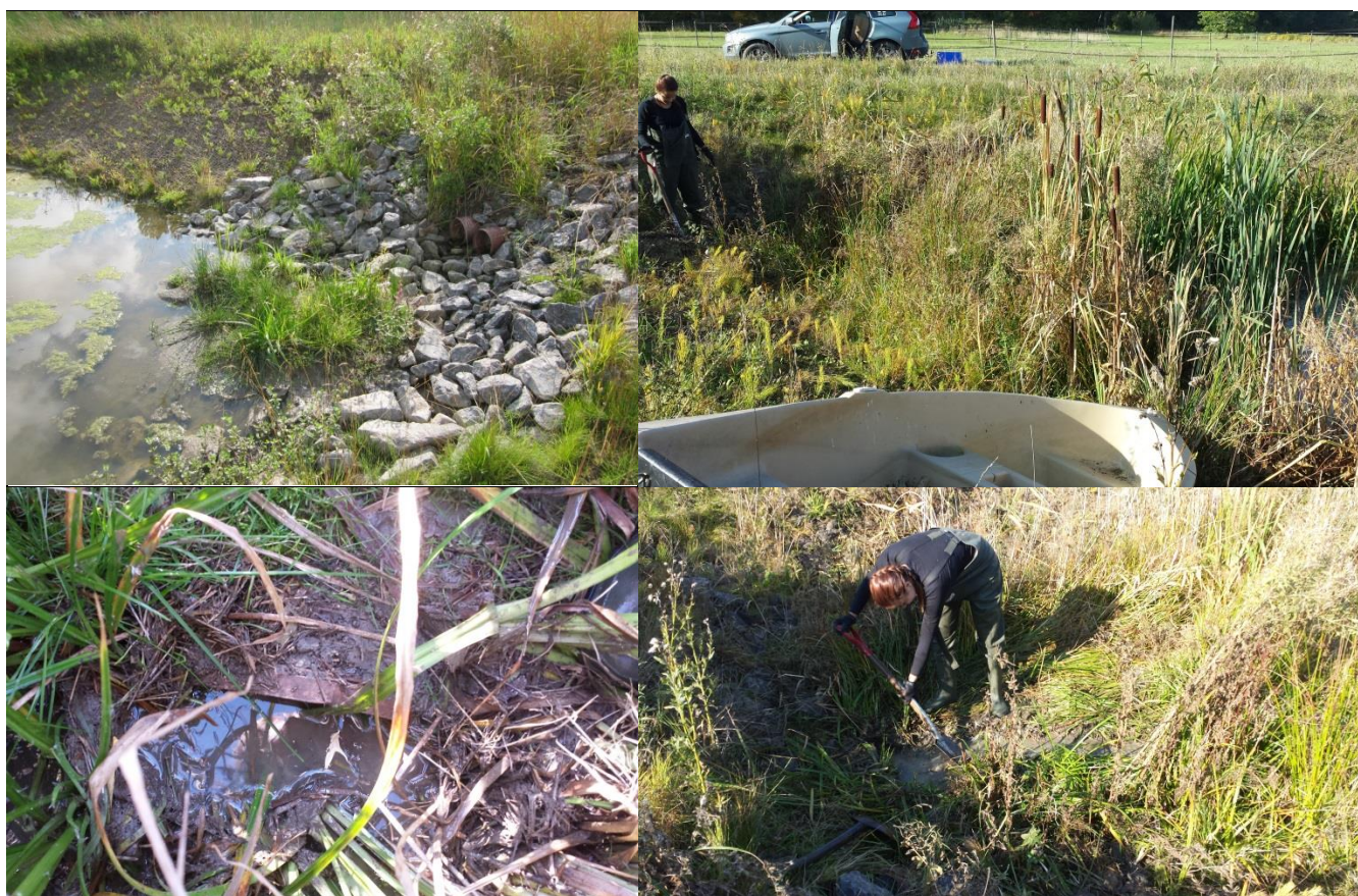
Figur 7. Bergaholm fosfordamms inlopp 2011 uppe till vänster 2011 och övriga bilder är från 2017. Rören från inloppsbrunnen som mynnar ut i dammens djupdel har fyllts med ansamlat sediment som förhindrar vatten och partiklar att flöda ut i dammen. Mycket vegetation har etablerats på det ansamlade sedimentet (Foto: Pia Geranmayeh (Kynkäänniemi).
