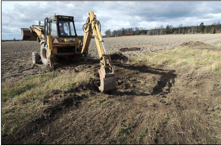
Grävning av mikrovåtmark, "Altomta", april 2018.
